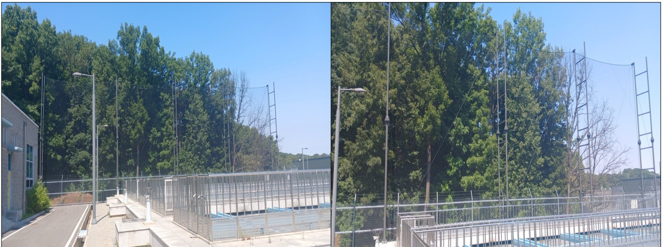
제3침전지 그물망 설치 완료
