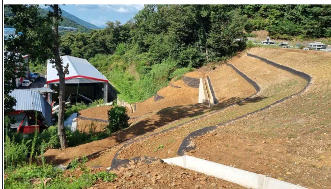
산사태 복구공사 완료(옹벽설치, 배수공사)
