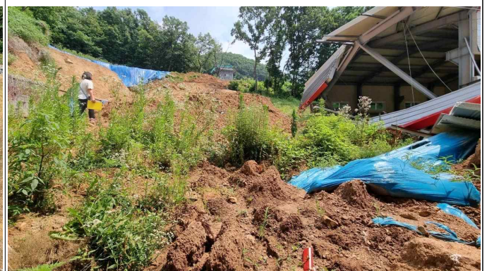
산사태 복구공사 미완료 부분 (유실토사 폐기처리 및 산사태지 하단부 복구공사)
