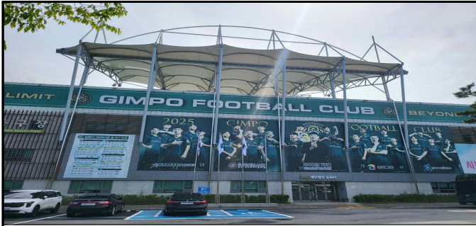
경기장 외벽 설치
